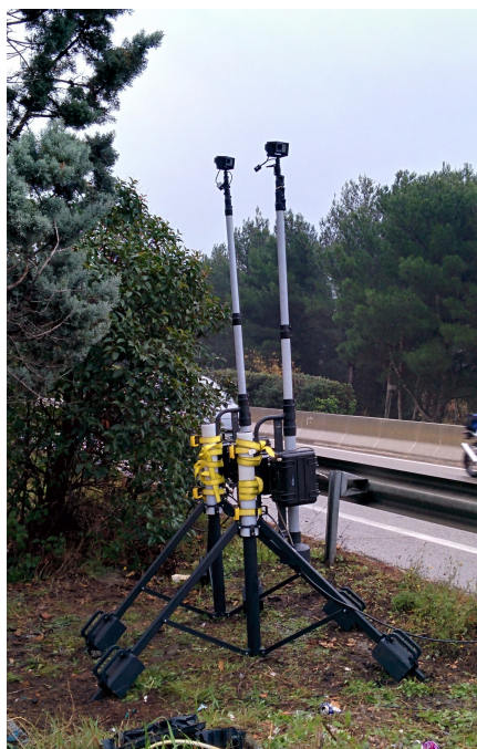
Illustration 2: Deux capteurs SCOUT VCU installés en bord de chaussée
